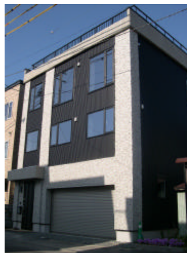
ガルバ鋼板仕上げ
