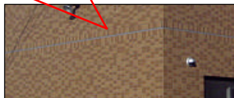
内断熱工法の打ち継ぎ対策
